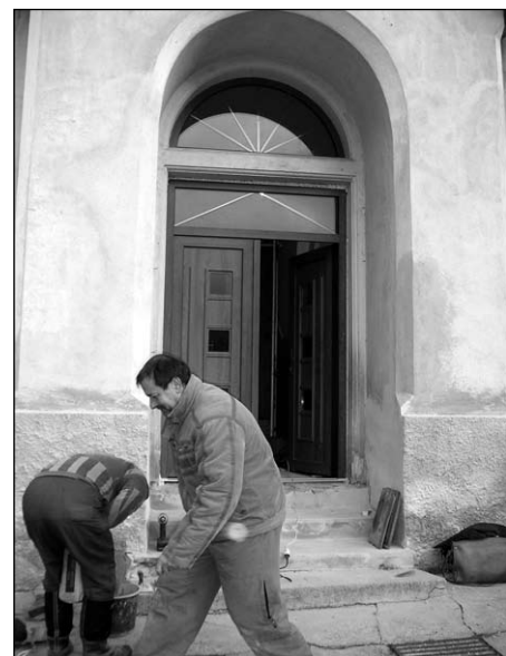
Výmena vstupných dverí kostola
